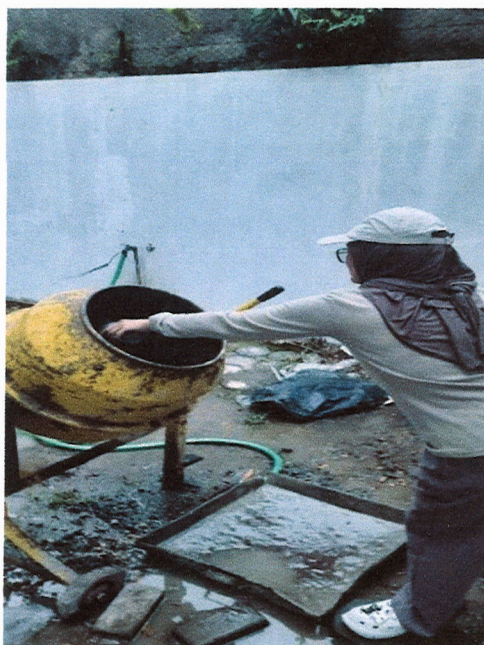
Gambar 4. 1 Pelaksanaan Pembuatan Beton Porous
