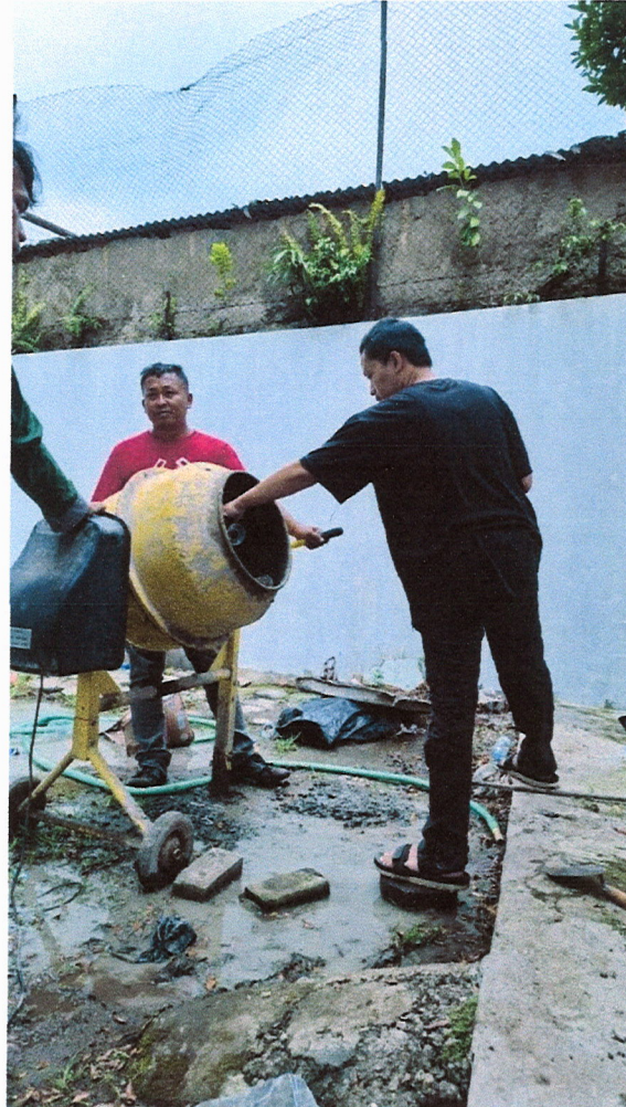
Gambar 4. 2 Pelaksanaan Pembuatan Beton Porous
