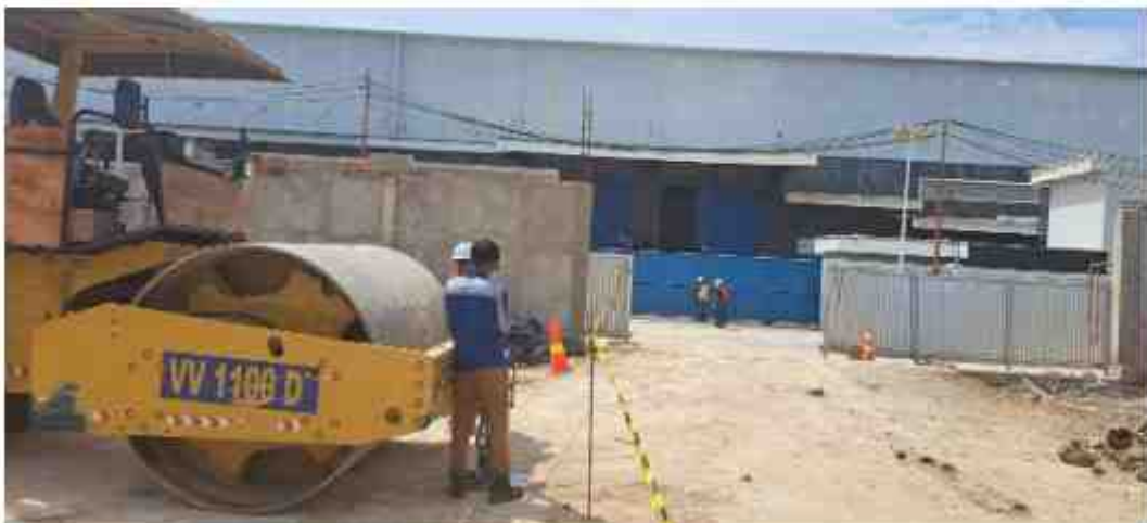
Gambar 4.4 Pengukuran Jarak Mesin Vibro Terhadap Bangunan 25 Meter
