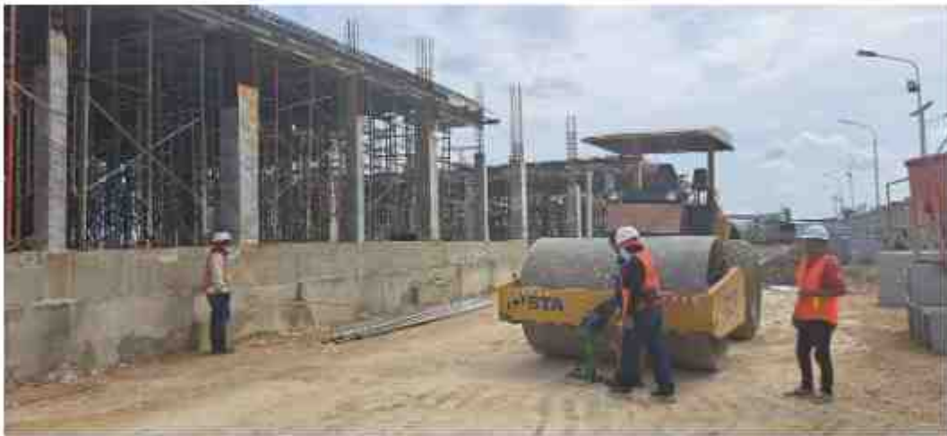
Gambar 4.3 Pengukuran Jarak Mesin Vibro Terhadap Bangunan 5 Meter
