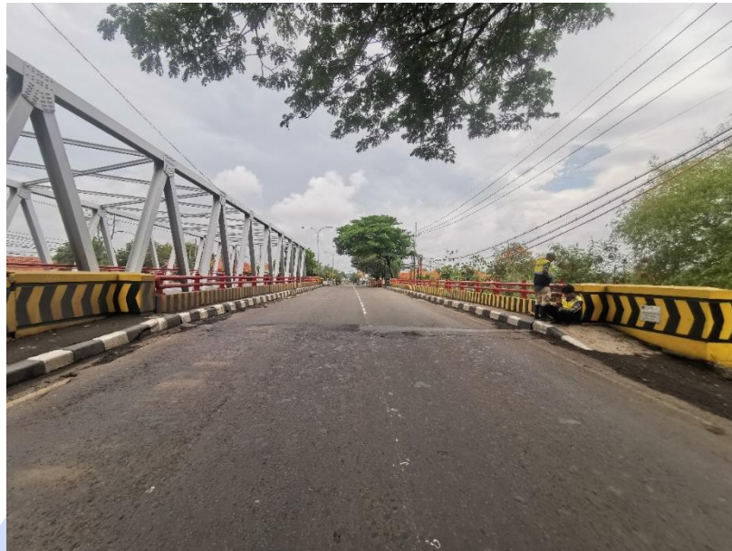
Gambar 1.8 Jembatan Bangka Deres B
