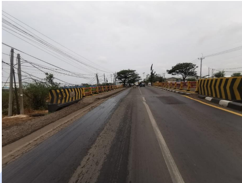
Gambar 1.6 Jembatan Paluh A
