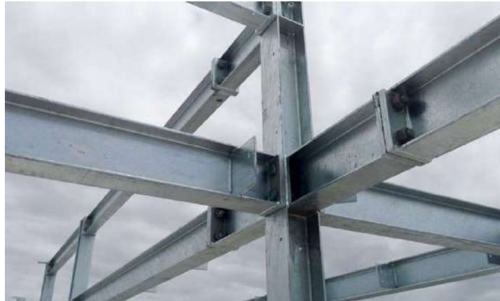
Gambar 1.3 Sambungan Baja Kolom-Balok.
