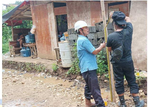
Pengukuran Ulang & Pemasangan Patok Kemiringan
