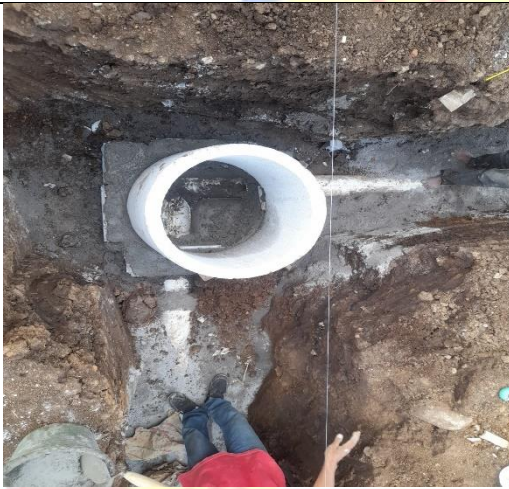
Pemasangan Buis Beton untuk Mainhole
