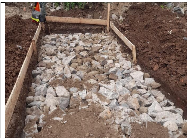
Pengurangan Sirtu untuk Pondasi IPAL Biofilter
