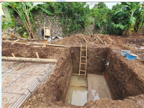
Lantai Kerja Bak Penangkap Pasir dan Ekualisasi
