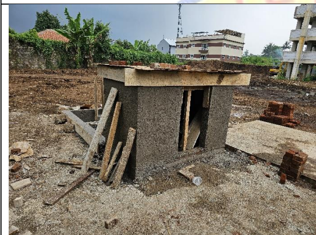
Plesteran untuk Rumah Pompa
