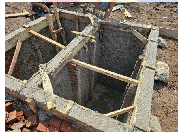
Pengecoran Ring Balok dan Plesteran Bak
