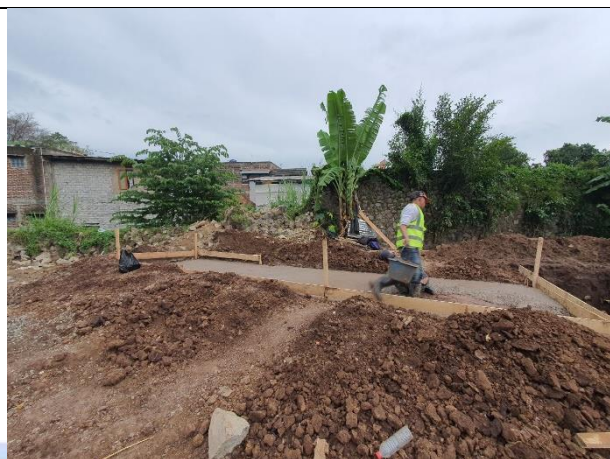
Lantai Kerja untuk Pondasi IPAL Biofilter
