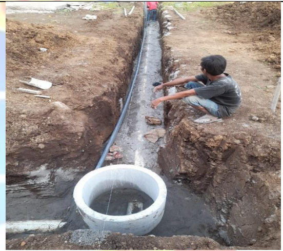
Pemasangan Buis Beton untuk Mainhole
