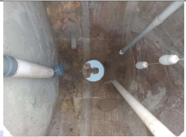
Kondisi Dalam Ipal Sebelum Setting Lamela
