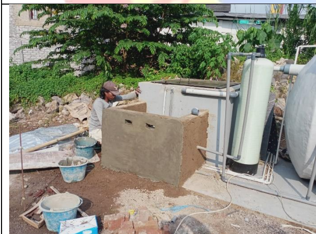
Finishing Rumah Pompa
