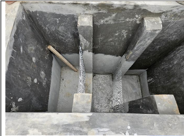
Pemasangan Kawat Galvanis di Bak Penangkap Pasir
