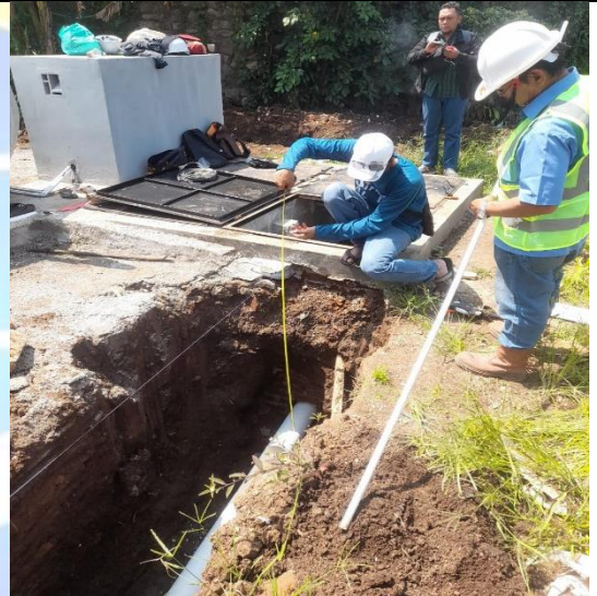
Pengukuran Ulang & Cek Kemiringan
