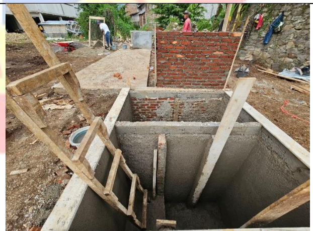
Pekerjaan Rumah Pompa
