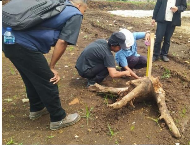
Pengukuran Ulang & Pemasangan Patok Kemiringan
