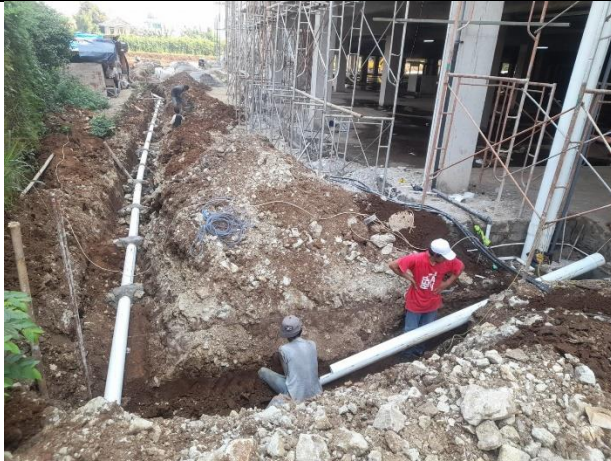
Konekting Mainhole Awal ke Pipa Induk
