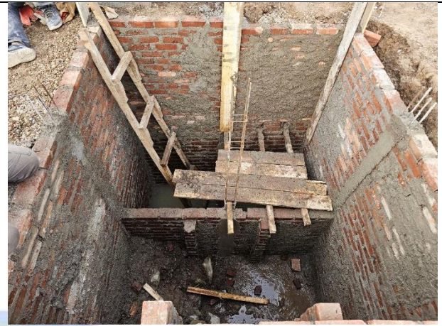
Pasangan Bata Bak Penangkap Pasir dan Bak Ekualisasi
