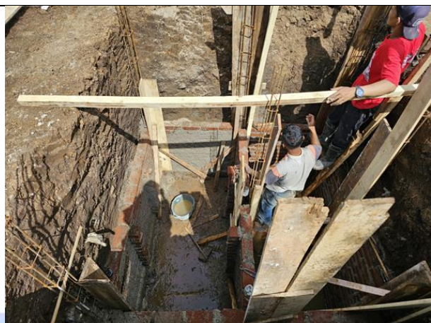
Pasangan Bata Bak Penangkap Pasir dan Ekualisasi
