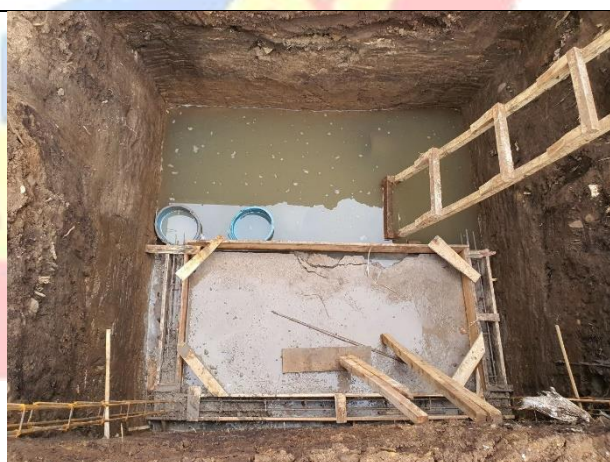
Pembesian Sloof Lantai Bak Penangkap Pasir dan Ekualisasi
