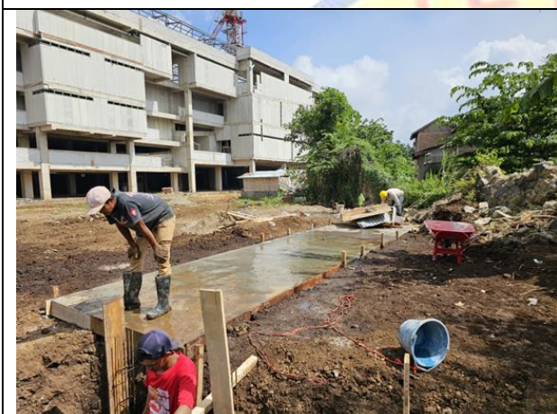
Persiapan Pembuatan Bak Penampung Akhir
