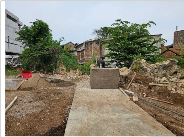
Plesteran untuk Bak Indikator
