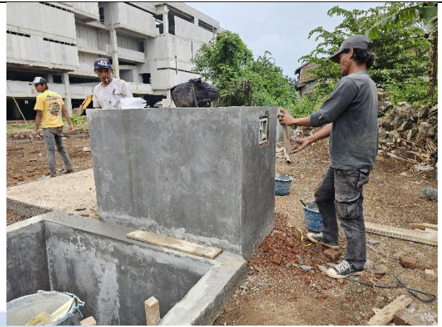
Pemasangan Rooster untuk Sirkulasi Udara Rumah Pompa
