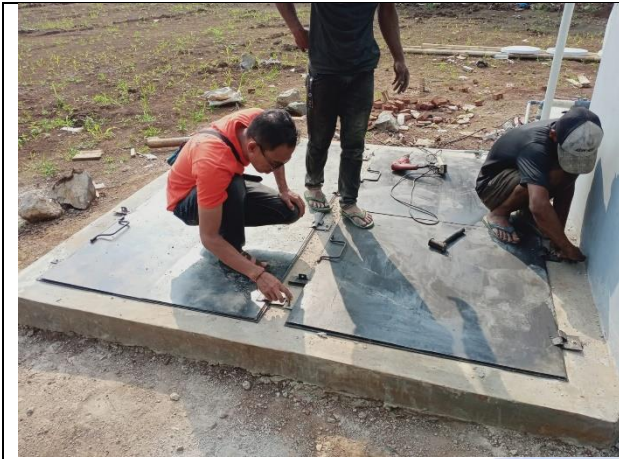
Pemasangan Tutup Baja untuk Bak Penangkap Pasir Dan Bak Ekualisasi
