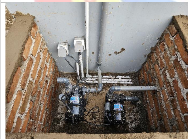
Pembuatan Rumah Pompa bagian Bak Indikator
