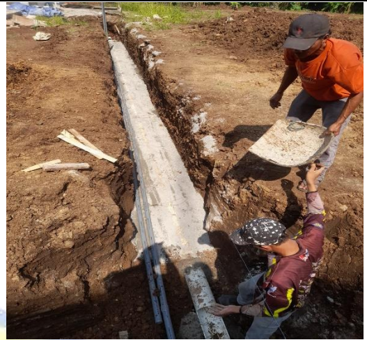
Pengurugan Pasir pada Pipa Jaringan
