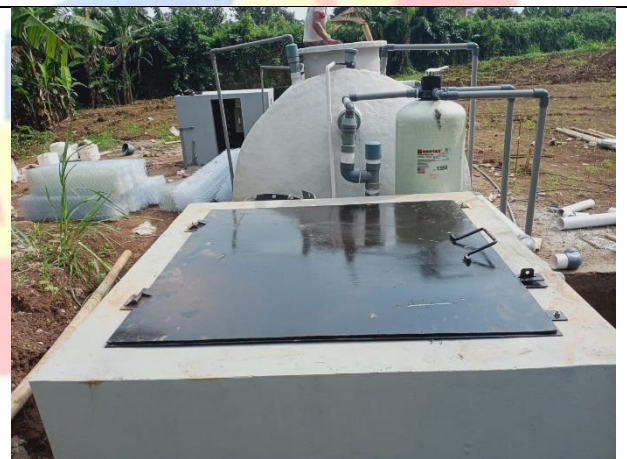
Pemasangan Tutup Baja Bak Indikator
