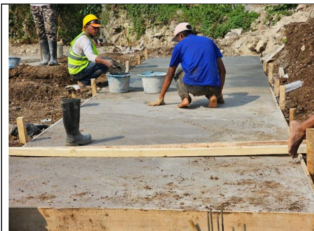
Acian untuk Pondasi IPAL Biofilter
