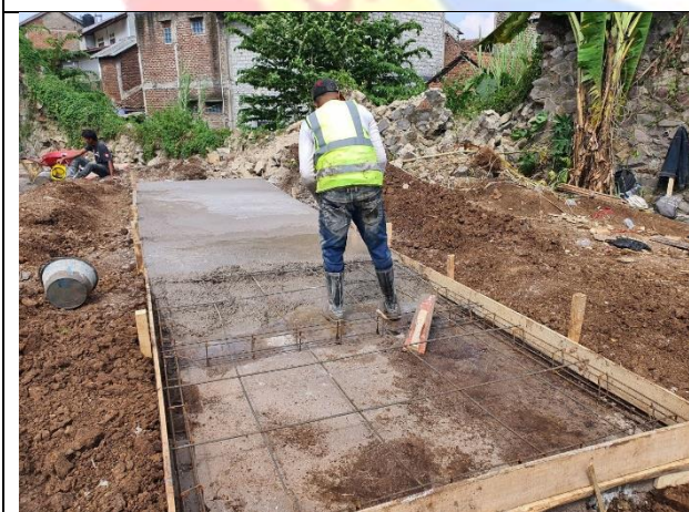
Coran Lantai untuk Pondasi IPAL Biofilter
