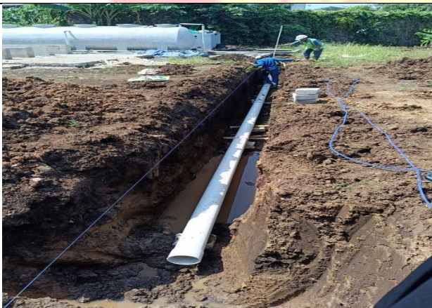
Konekting Pipa induk Ke bak penampung Awal
