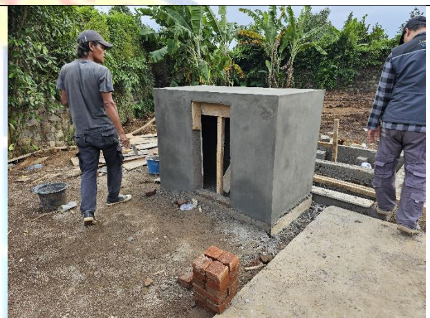
Acian untuk Rumah Pompa
