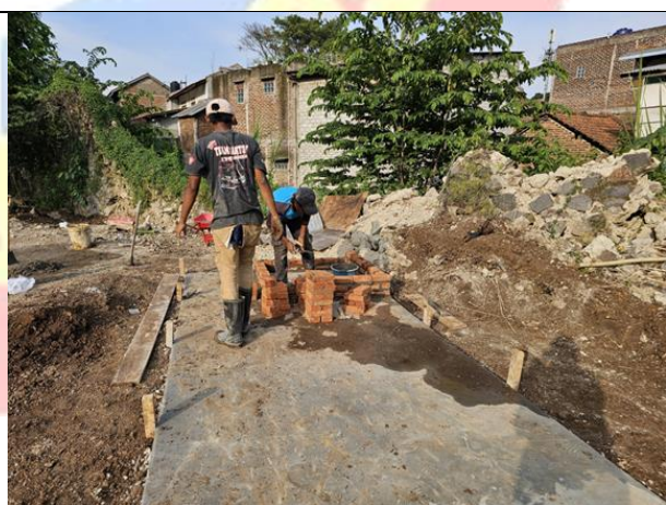
Pasangan Bata untuk Bak Indikator
