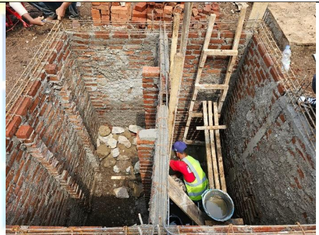
Pembesian Ring Balok Bak Penangkap Pasir dan Ekualisasi
