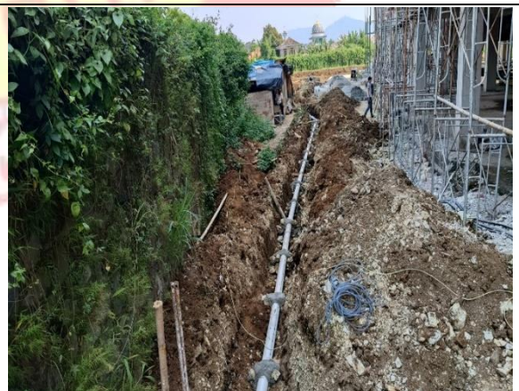
Pemasangan jalur Induk Pipa Ipal
