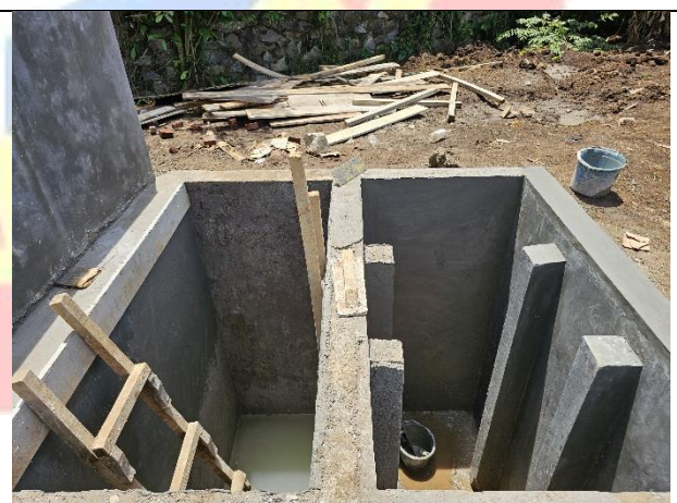
Acian dan Waterproofing untuk Bak Penangkap Pasir, Bak Ekualisasi 1 dan Bak Ekualisasi 2
