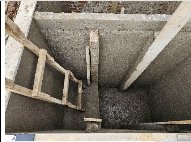
Plesteran untuk Bak Penangkap Pasir
