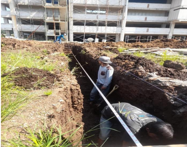
Pengukuran Ulang & Cek Kemiringan
