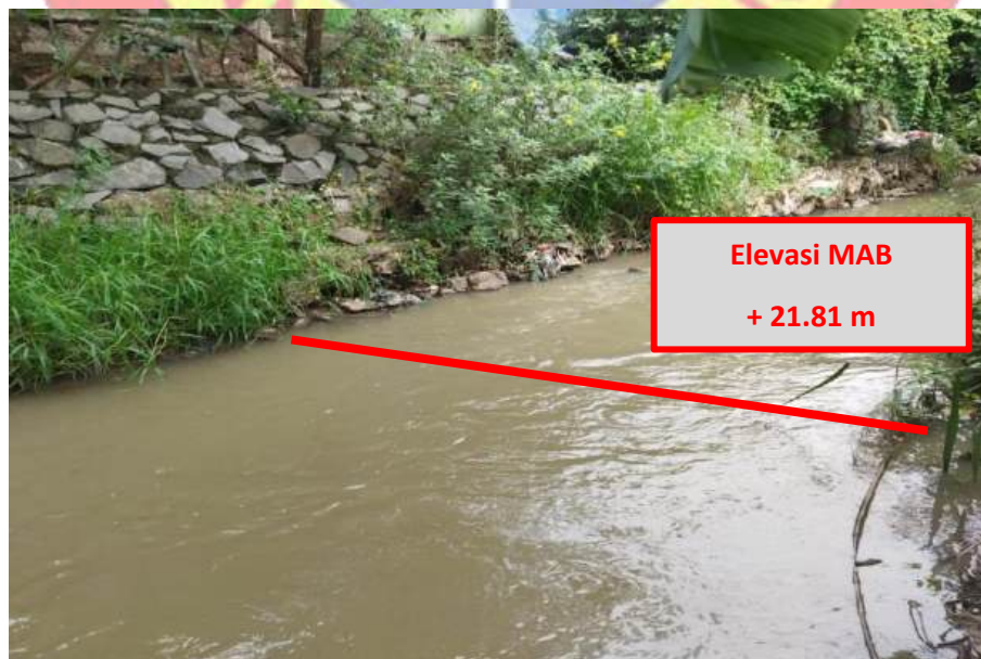
Gambar 4. 8. Kondisi Eksisting Saluran Pembuang DED Embung Sukamulya
