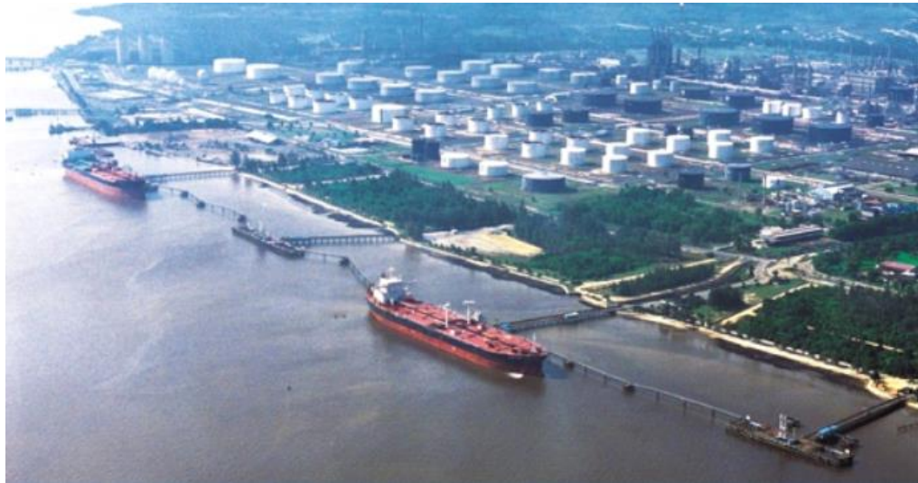
Gambar 1-1. Jetty Sumber : Google image
