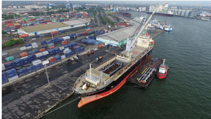
Gambar II-3 Jetty Sumber : google image
