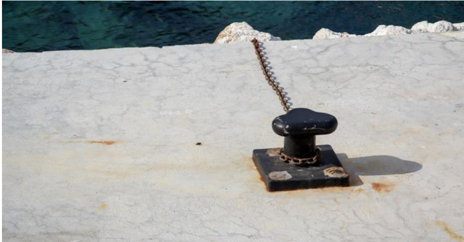
Gambar II-27 Bollard ginjal dan tee
