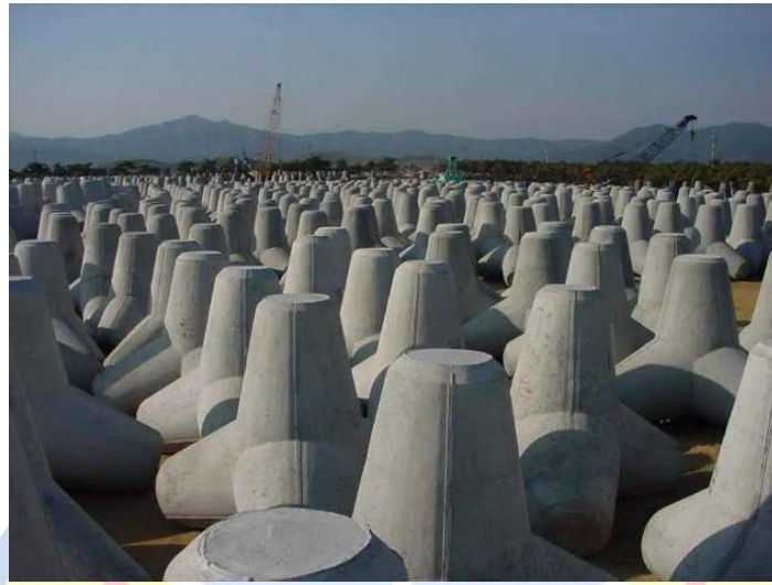
Gambar 1.2 Beton Tetrapod Pemecah Gelombang Laut
