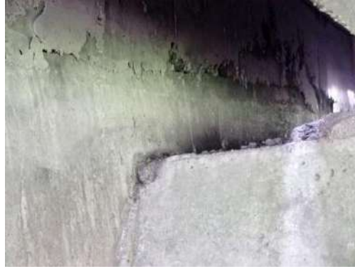
Tembok Kepala Jembatan
