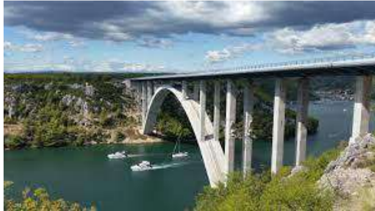
Gambar 2.5 Jembatan pelengkung ( arch bridge )
