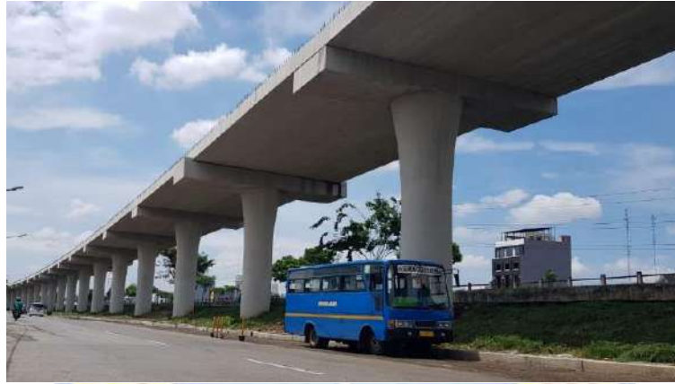
Gambar 2.2 Jembatan pelat berongga ( voided slab bridge )
