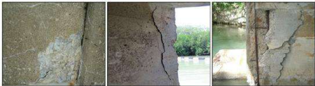
Gambar 2.27 Ilustrasi kode kerusakan 205 Pecah atau Hilangnya Bahan (Delaminasi, Abrasi, Aus) dari Kiri ke Kanan Kerusakan Bertambah Parah dan atau Volume Semakin Luas (Wisconsin DOT, 2020)
