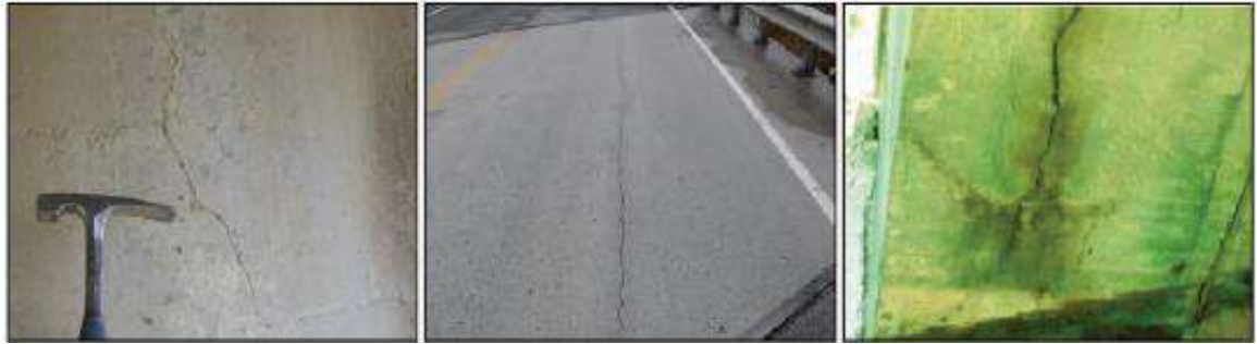
Gambar 2.24 Ilustrasi Kode Kerusakan 202 Retak (Elemen Beton), dari Kiri ke Kanan Kerusakan pada Beton Bertulang Bertambah Parah dan atau Volume Semakin Luas (Wisconsin DOT, 2020)
