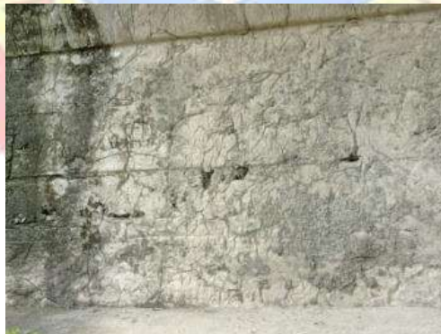
Dinding kepala Jembatan
