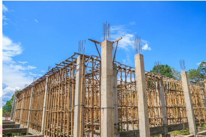
Gambar 1. 9 Pembuatan Kolom
