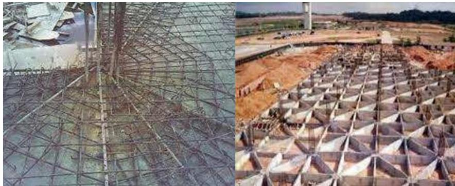
**Gambar 2.11** Fondasi konstruksi sarang laba-laba
