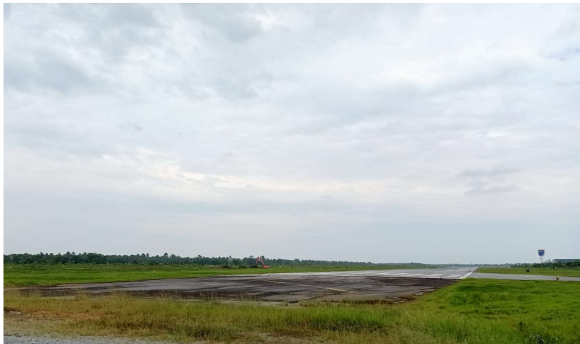
Gambar 1.5 Lokasi Stopway Existing
