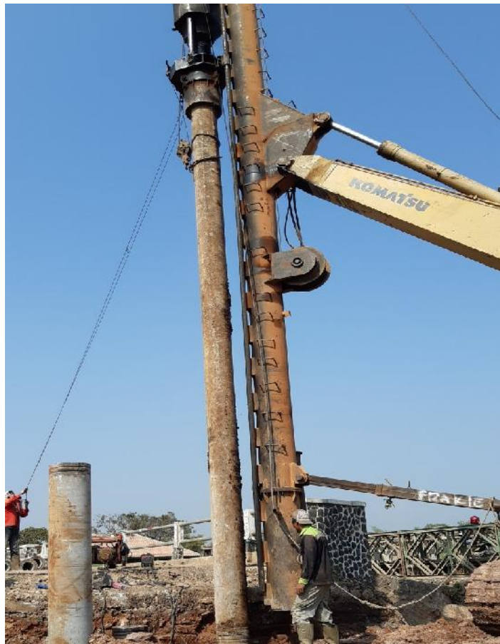
Gambar 4.3 Proses Pemancangan Tiang Pancang Dengan Diesel Hammer
