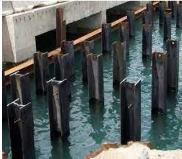
Gambar 2.11 Fondasi Tiang Baja
