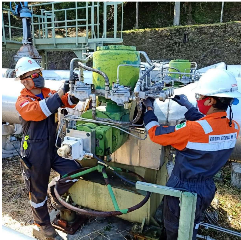
Gambar 1. 1 Proses kalibrasi katup steam venting oleh tim pemeliharaan
