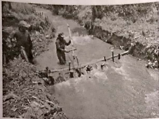
Gambar 2 Kerusakan Jaringan Irigasi Wanir
