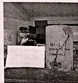
Gambar 6. Pola kerusakan pada beton normal
