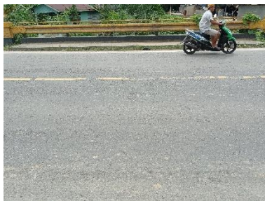
Lapisan permukaan yang kasar
