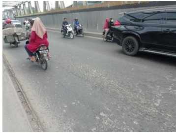
Lapisan permukaan retak
