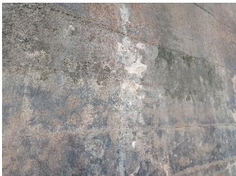
Dinding kepala jembatan/pilar
