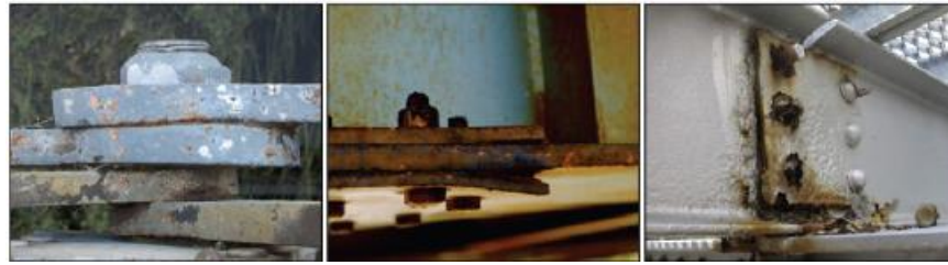
Gambar 2.29 Ilustrasi Kode Kerusakan 308 Sambungan yang Longgar, dari Kiri ke Kanan Kerusakan Bertambah Parah atau Volume Semakin Meluas (Wisconsin DOT, 2020)
