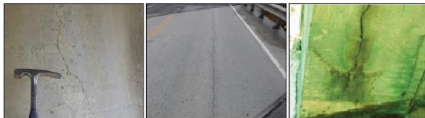
Gambar 2.20 Ilustrasi Kode Kerusakan 202 Retak (Elemen Beton), dari Kiri ke Kanan Kerusakan pada Beton Bertulang Bertambah Parah dan atau Volume Semakin Luas (Wisconsin DOT, 2020)
