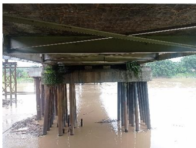
Aliran air utama (penumpukan debris)
