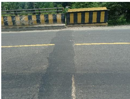
Sambungan siar muai retak
