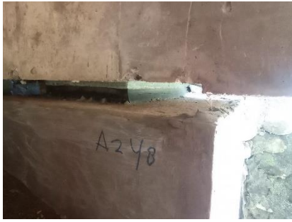
Landasan karet berubah bentuk
