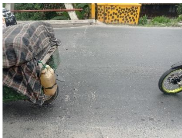
Siar muai retak sambungan aspal
