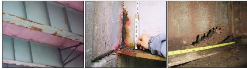
Gambar 2.26 Ilustrasi Kode Kerusakan 302 Karat, dari Kiri ke Kanan Kerusakan Bertambah Parah atau Volume Semakin Meluas (Wisconsin DOT, 2020)
