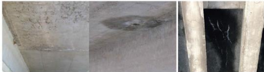
Gambar 2.22 Ilustrasi Kode Kerusakan 204 Kotor, Berlumut, Penuaan atau Pelapukan Beton, Rembesan, dari Kiri ke Kanan Kerusakan Bertambah Parah dan atau Volume Semakin Luas (Wisconsin DOT, 2020)
