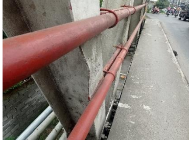
Batang diagonal berubah bentuk
