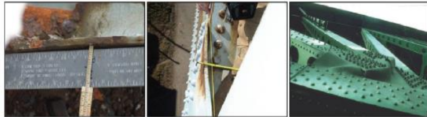
Gambar 2.27 Ilustrasi Kode Kerusakan 303 Perubahan Bentuk pada Komponen, dari Kiri ke Kanan Kerusakan Bertambah Parah atau Volume Semakin Meluas (Wisconsin DOT, 2020)
