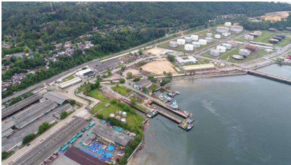
Gambar 1.1 Pelabuhan Proyek Jetty 6A, RDMP RU V Balikpapan, PT. Pertamina Balikpapan, Indonesia
