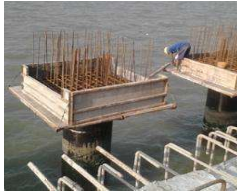
Gambar 2.25 Pemasangan Beton Pada Catwalk Support
