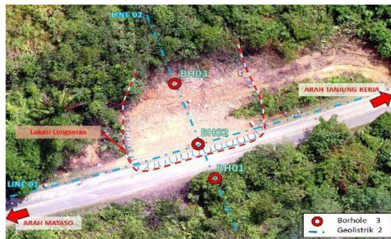
Gambar 4. 2Tampak atas Lokasi Longsoran Ruas Jalan kota Simpang – Sp.Nangasilat Km 448+650 Kalimantan Barat
