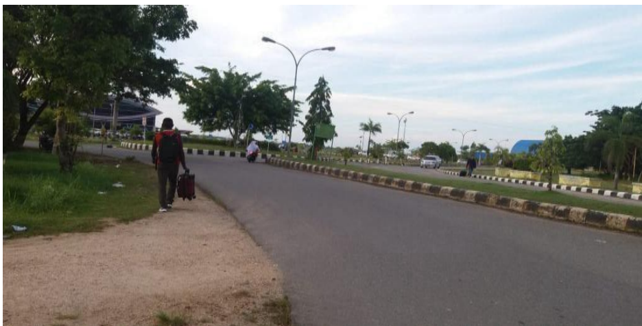
Gambar 2.7 Akses Jalan Masuk Bandar Udara Domine Eduard Osok (Sumber : Direktorat Jendral Perhubungan Udara)
