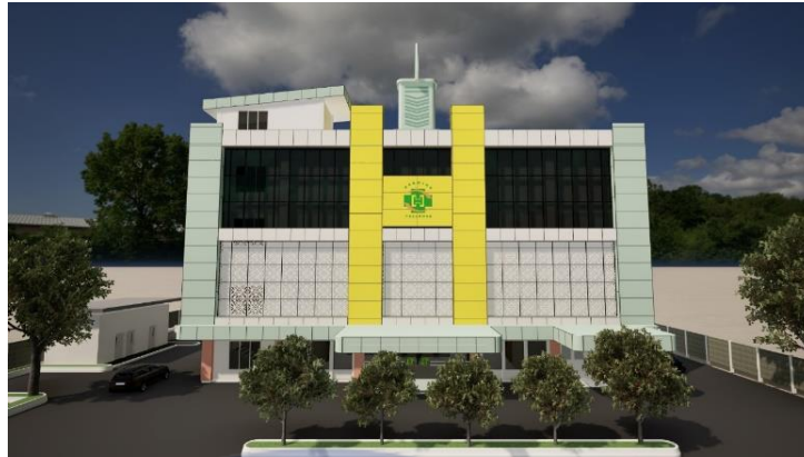
Gambar 4.1 Tampak Bangunan Depan
