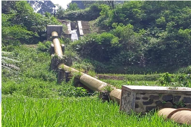
Gambar 2.6. Pondasi dan Dudukan Pipa Pesat
