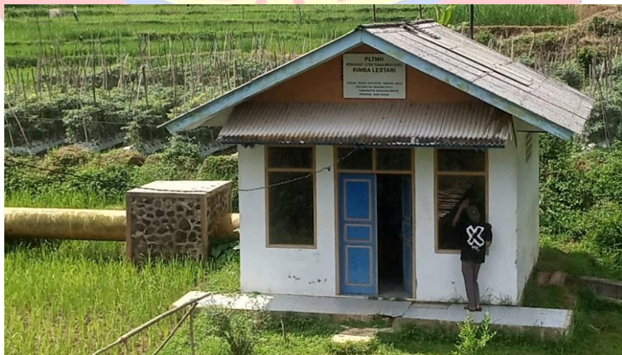
Gambar 2.7 Rumah Pembangkit ( Power House )
