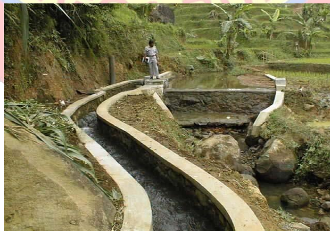
Gambar 2.1 Diversion Weir dan Intake (Dam/Bendungan Pengalih dan Intake )
