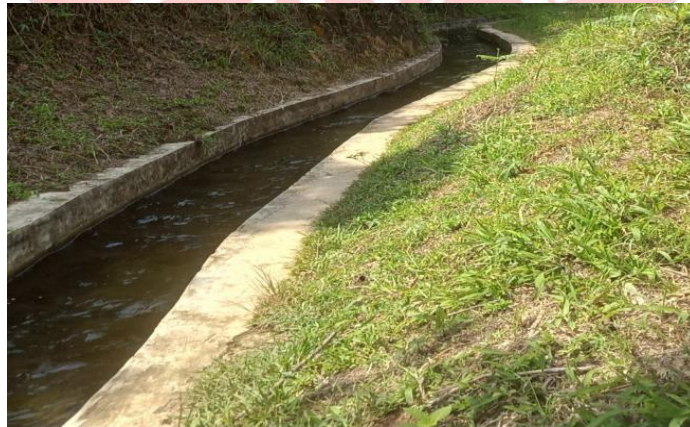
Gambar 2.3. Head Race (Saluran Pembawa)
