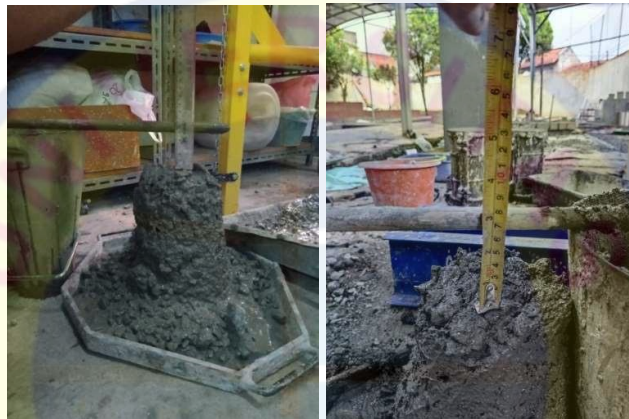
Gambar 4.5 Pengujian Slump Beton
