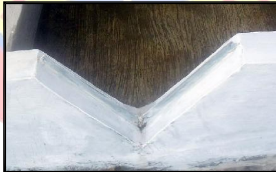
Gambar 3.6 : Bangunan Spill Way (Bendung)
