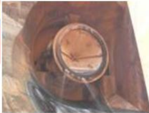
Gambar 3. 15 Hollow Jet Katup ((Doc PJT II).
