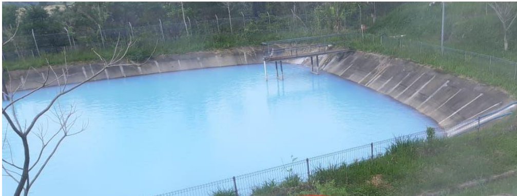
Gambar 2. 8 Cooling pond lapangan panas bumi area Ulubelu
