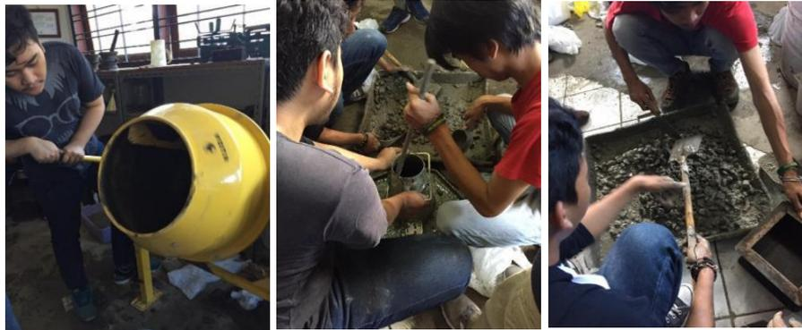
**Gambar 4.3.**Pencampuran Beton Secara Manual
