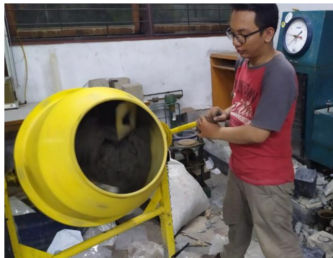
Pengadukan material beton
