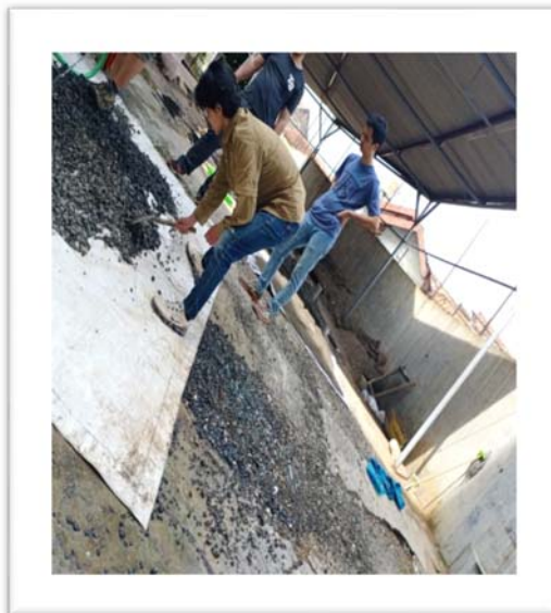
Pengeringan Agregat Kasar setelah di cuci
