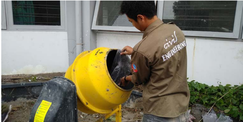
Proses pencampuran bahan-bahan menggunakan molen mini
