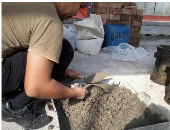
Gambar 4.1. pencampuran beto secara manual
