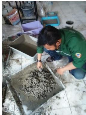
**Gambar 4.14** Proses Pencampuran Beton
