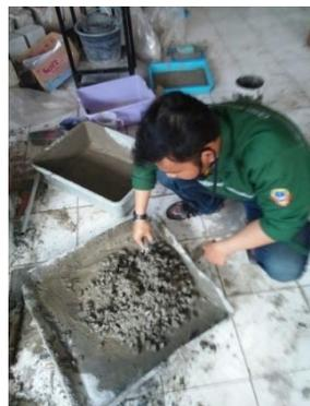
**Gambar 4.3** Pencampuran Beton Secara Manual
