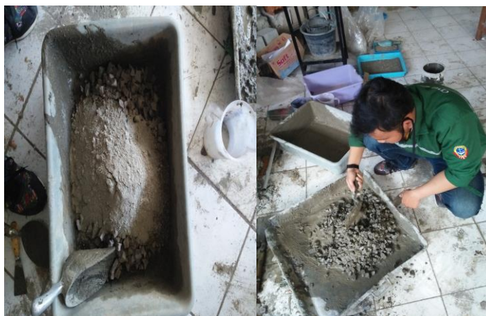
Gambar 12. Proses pemasangan dan pencampuran bahan material
