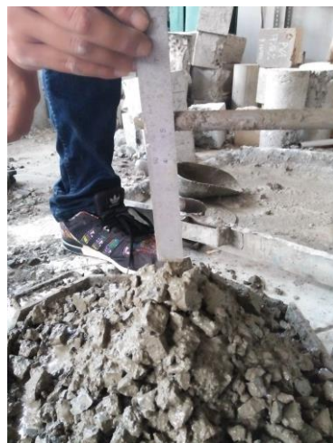
Gambar 14. Proses Pengukuran Nilai Slump
