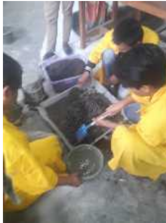
Gambar 4.5 Pencampuran Beton Normal Secara Manual
