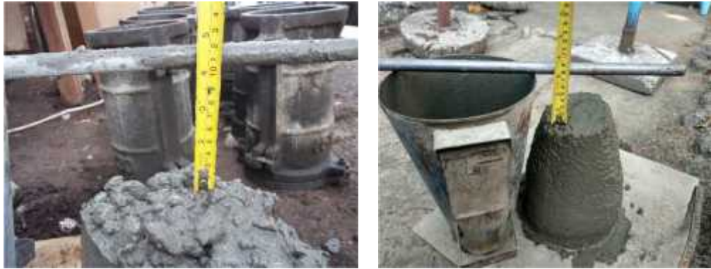
Gambar 3.8 Proses Pembuatan Benda Uji
